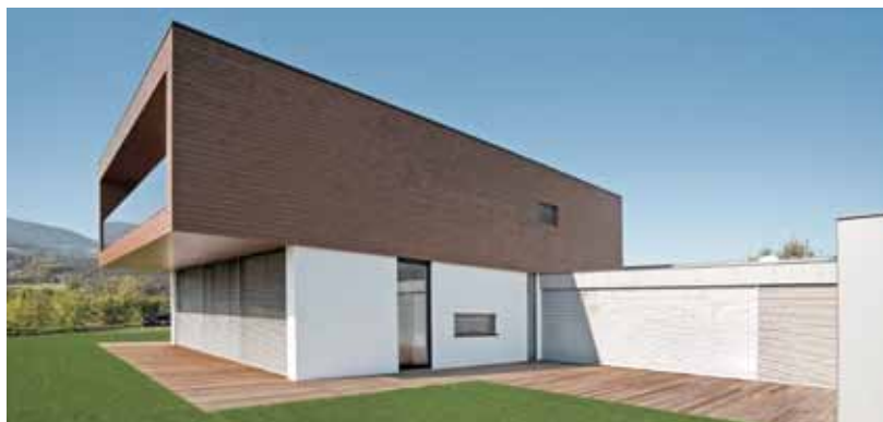
Een voorbeeld uit de praktijk: toepassing van StoTherm Wood bij een passiefhuis. Eengezinswoning Retter, Oostenrijk- Ratten, Reinhard Hausbauer, Oostenrijk- Ratten
