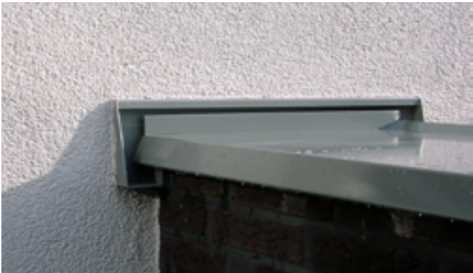
Dankzij een Sto-HAP aansluiting worden haakse gevelverbindingen koudebrugvrij en netjes gerealiseerd.
