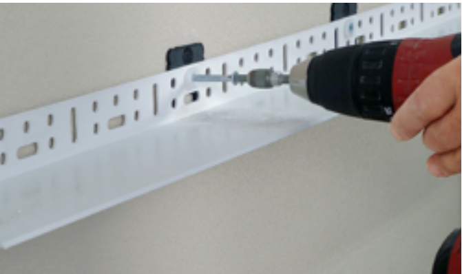
Een wit gepoedercoat aluminium startprofiel geeft een vormvaste basis. Zo bent u verzekerd van een correcte start van het systeem.
