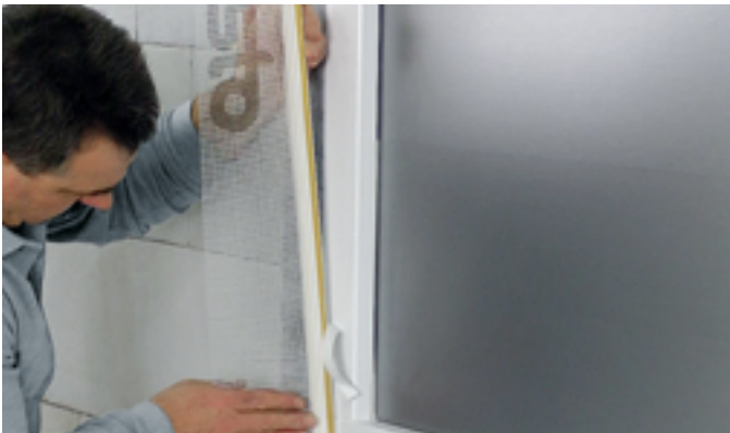
Een aansluitprofiel zorgt voor een strakke aansluiting tussen het buitengevelisolatie systeem en het kozijn.
