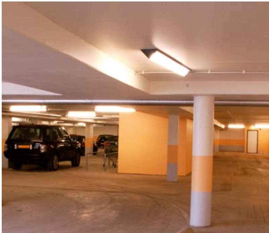
Wandafwerking in een parkeergarage
